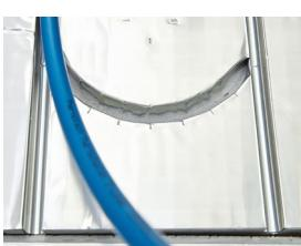
Двигаясь по рисунку, соответствующему способу укладки трубопровода, вернуться к распределительному коллектору и отрезать трубу с запасом 20-30 см.
